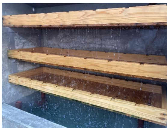
(写真左：家族湯の浴槽 右：ヒノキ製温泉冷却装置)
